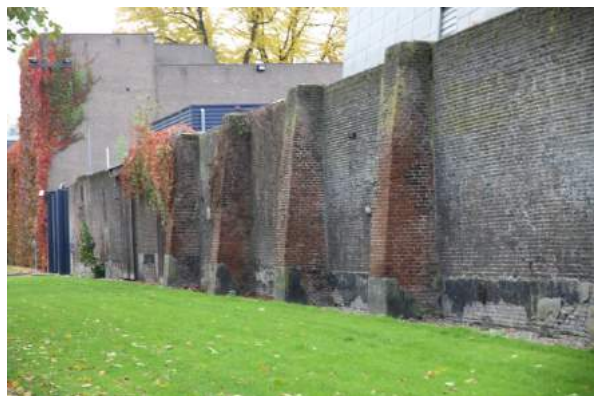
Afb. 3. Monumentale 17de-eeuwse muur die het Marineterrein afsluit.
